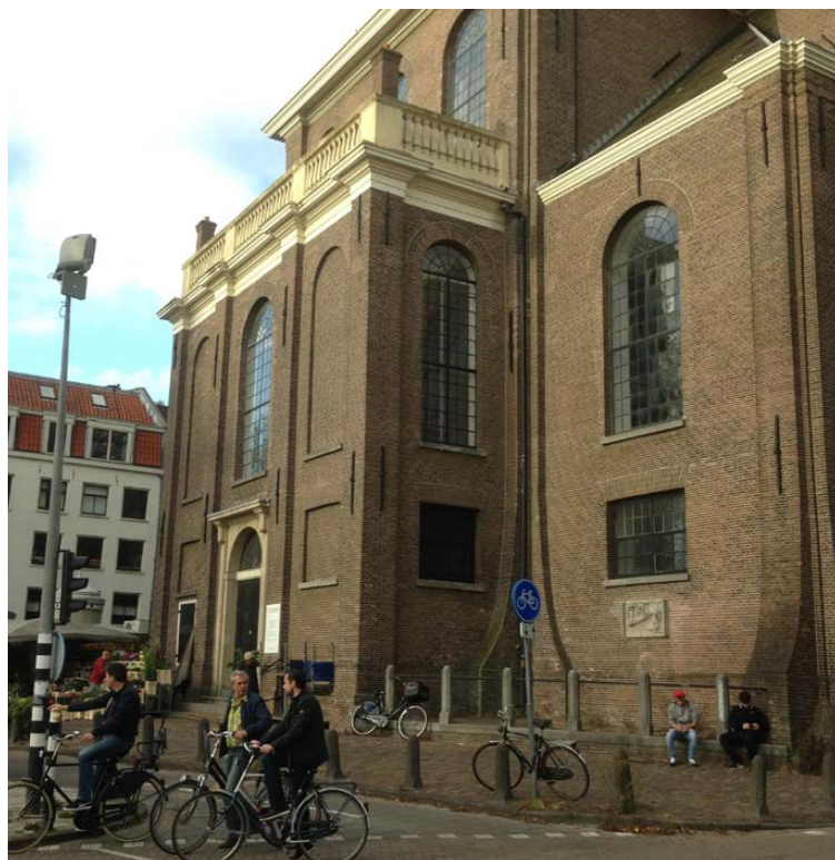
8 De voorbouw met de hoofdingang. Foto auteur, 2017.
